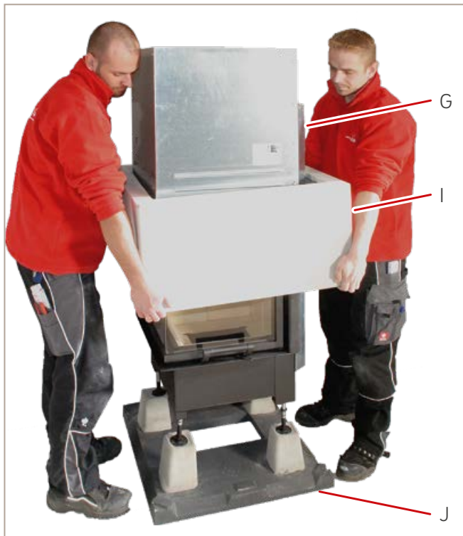
Abb.18: Unterbauteil setzen
