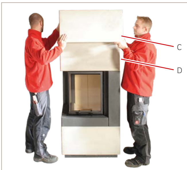
Abb.22: Oberbauteil 2 setzen
